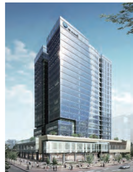
일산 대방 노블레스 타워 1,2 Deabang Nobleness Tower 1,2 대지면적 : 12,646㎡, 연면적 : 55,322㎡ Site Area : 12,646㎡, G.F.A. : 55,322㎡ 일산시, 대한민국 Ilsan, Republic of Korea
