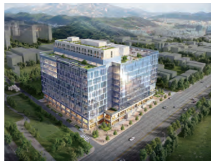
서대구 산업단지 지식산업센터 Seodaegu Industrial Park Center 대지면적 : 11,820㎡, 연면적 : 81,858㎡ Site Area : 11,820㎡, G.F.A. : 81,858㎡ 대구시, 대한민국 Daegu, Republic of Korea
