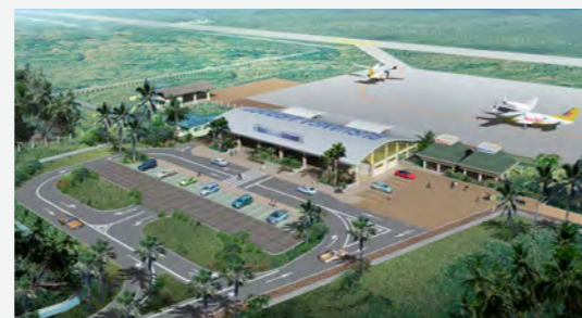
필리핀 부수앙가공항 개발사업 건설사업관리 Construction Management for Philippines Busuanga Airport 연면적: 2,200㎡, 위치: 필리핀 부수앙가 G.F.A: 2,200㎡, Location: Busuanga, Philippines 한국국제협력단 Korea International Cooperation Agency
