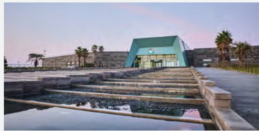
2012 제주해양과학관 건립 민간투자시설사업 건설사업관리 Construction Management for Aqua Planet in Jeju 연면적 : 25,893㎡ 규모 : 지하 1층 / 지상 2층 위치 : 제주도 서귀포시 G.F.A : 25,893㎡ SCALE : B1F / 2F LOCATION : Seogwipo-si, Jeju-do 제주특별자치도 Jeju-do
