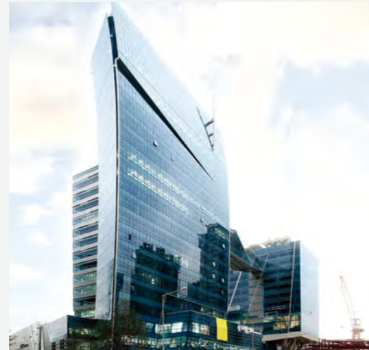
누리꿈스퀘어 신축공사 건설사업관리 Construction Management for Nuri-kum Square 연면적: 151,940㎡ 규모: 지하4층, 지상22층 위치: 서울 마포구 G.F.A: 151,940㎡ Scale: 4 basement level, 22 ground Floors Location: Mapo-gu, Seoul 정보통신산업진흥원 National IT Industry Agency
