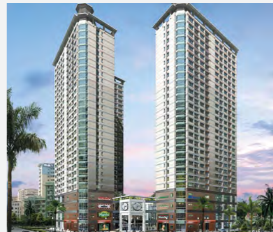
베트남 탕롱 28층 주상복합빌딩 Vietnam 28 Story Residential Complex Building 시설규모 : -수전용량: 22.9kV, 6,000kVA Facility scale: -R.E.C: 22.9kV, 6,000kVA
