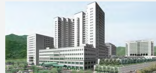
동두천 제생병원 기본 및 실시설계 Preliminary and Detailed Design for Hospital, in Dongducheon 연면적 : 147,804㎡, 서울시 G.F.A. : 147,804㎡, Seoul 보현종합건설(주)
