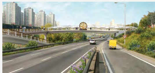
중랑천 체육공원 진입시설 설치 기본 및 실시설계 Preliminary and Detailed Design for Jungrang-cheon Sports Park Access Structure 보행육교: 37.0m/1개소 주형: 37.0, 경사로: 65.0m U-Type: 12.5m, 1 Foot Bridge: 37.0m Main Girder: 37.0 m, Slop Way: 65.0m, U-Type: 12.5m 광진구 Gwangjin-gu Office
