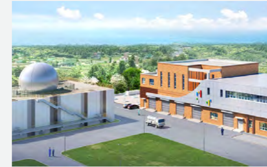
제주시 가축분뇨 공공처리시설 설치사업 실시설계 Detailed Design for Installation of Public Treatment Facilities for Livestock Manure in Jeju-city 위치 : 제주특별자치도 사업면적 : 30,482㎡, 시설용량 : 230㎡/일 Location : Jeju city Site area : 30,482㎡, Facility capacity : 230m³/day 한국환경공단, 금호산업(주) Korea Environment Corp.
