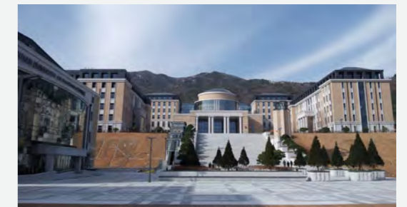
부산외국어대학교 남산동캠퍼스 기본 및 실시설계 Preliminary and Detailed Design for Busan University of Foreign Studies Namsan-dong Campus 시설규모 : -수전용량: 22.9kV, 10,000kVA Facility scale: -R.E.C: 22.9kV, 10,000kVA 부산외국어대학교 busan National University of Foreign Studies
