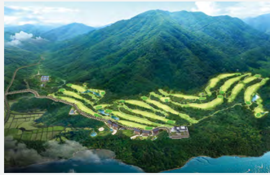
강화덕정 온천랜드 마스터플랜작성 Master Plan for Ganghwa Dukjung Hot-spring Land 면적 : 1,959,088㎡, 위치 : 인천광역시 강화군 Area : 1,959,088㎡, Location : Ganghwa-gun, Incheon (주)이스타코 E-Starco
