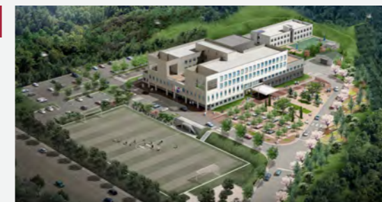
해양의료원 시설공사 건설사업관리 Construction Management for Maritime Medical Center 연면적: 15,188㎡ 규모: 지하 1층, 지상 4층 위치: 경상남도 창원시 G.F.A: 15,188㎡ Scale: 1 basement level, 4 ground Floors Location: Changwon-si, Gyeongsangnam-do 국방시설본부 Defence Installations Agency
