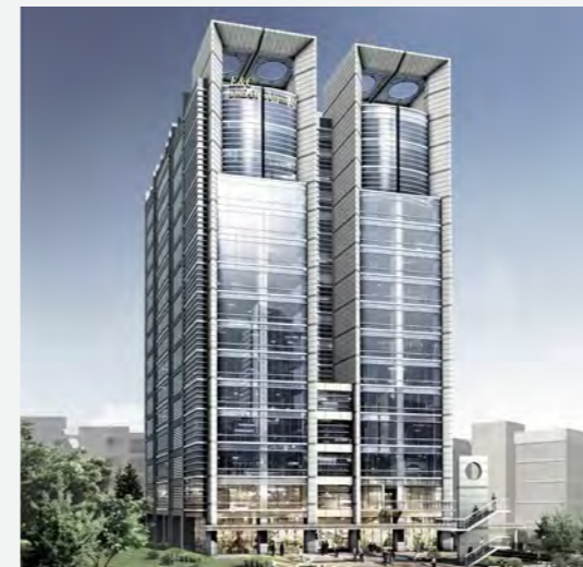
가산동 이앤씨 드림타워 9차 기본 및 실시설계 Preliminary and Detailed Design for E&C DREAM TOWER 9 대지면적 : 4,271㎡, 연면적 : 27,862㎡ 서울시 Site Area : 4,271㎡, G.F.A. : 27,862㎡ Seoul 이앤씨건설(주) E&C
