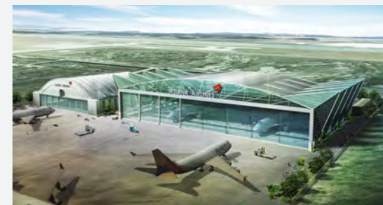
아시아나항공 인천공항 New Hanger 건립공사 건설사업관리 Construction Management for Asiana Airlines Incheon Airport New Hanger 연면적: 40,604㎡ 규모: 지하 1층, 지상 5층, 위치: 인천 중구 G.F.A: 40,604㎡ Scale: 1 basement level, 5 ground Floors Location: Jung-gu, Incheon 아시아나항공(주) Asiana Airlines
