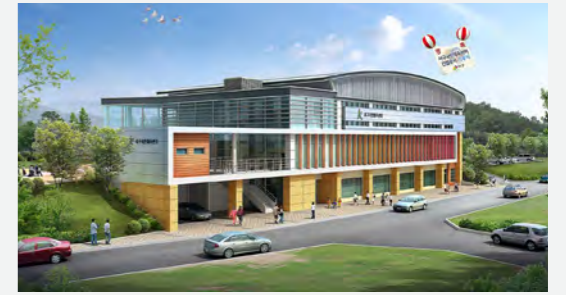
인천 서구 국민체육센터 건립공사 건설사업관리 Construction Management for National Sports Center in Seo-gu, Incheon 연면적: 5,402㎡ 규모: 지하 1층 / 지상 3층 위치: 인천광역시 G.F.A: 5,402㎡ Scale: B1F / 3F Location: Seo-gu, Incheon 인천광역시 서구 Seo-gu, Incheon
