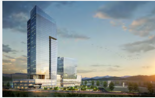
오성제지 지식산업센터 개발사업 건설사업관리 Construction Management for OsungPaper IT valley 연면적: 124,171㎡ 규모: 지하3층, 지상35층, 위치: 경기도 안양시 G.F.A: 124,171㎡ Scale: 3 basement level, 35 ground Floors Location: Anyang-si, Gyeonggi-do (주)오성제지 Osung Paper
