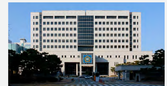
대전지방법원 천안지원청사 신축공사 건설사업관리 Construction Management for Daejeon District Court' Cheonan Branch 연면적: 24,130㎡ 규모: 지하1층, 지상8층 위치: 충청남도 천안시 G.F.A: 24,130㎡ Scale: 1 basement level, 8 ground Floors Location: Cheonan-si, Chungcheongnam-do 법원행정처 Court Of Korea
