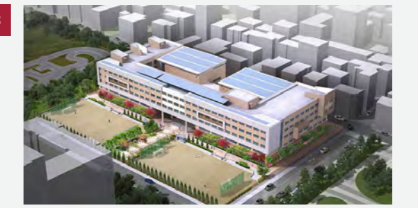
가락1초,중 신축 및 가락초 증축공사 건설사업관리 Construction Management for Garak 1 Elementary School and Middle School 연면적 : 27,519㎡ 규모 : 지하 1층 / 지상 5층 위치 : 서울특별시 송파구 G.F.A : 27,519㎡ SCALE : B1F / 5F LOCATION : Songpa-gu, Seoul 서울특별시 교육청 Seoul Metropolitan Office Of Education
