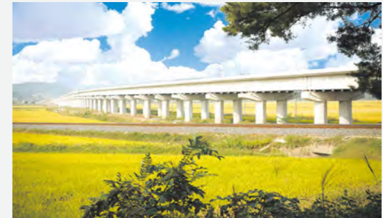
서해선(홍성-송산)복선전철 제3공구 노반시설 기타공사 보완설계) Preliminary and Detailed Design for Seohae Railway Section 3 길이: 7.601km Length: 7.601km 철도시설공단 Korea Rail Network Authority
