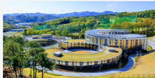
한화리조트 용인 리뉴얼공사건설사업관리 Construction Management for Hanwha Yongin Resort Renewal 연면적: 24,187㎡ 규모: 지하1층, 지상6층, 위치: 경기도 용인시 G.F.A: 24,187㎡ Scale: 1 basement level, 6 ground Floors Location: Yongin-si, Gyeonggi-do 한화호텔앤드리조트(주) Hanwha Hotels & Resorts
