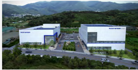
백신안전기술지원센터 백신 해외인증 허가 규제인력 교육동 건립 건설사업관리 Construction Management for Vaccine Safety Technology Support Center 연면적 : 4,868㎡, 규모: 지상 3층 위치 : 전라남도 화순군 G.F.A: 4,868㎡, SCALE : 3F, Location : Hwasun-gun, Jeollanam-do 백신안전기술지원센터 Vaccine Center of Assisting Safety & Technology
