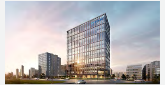
영등포 디스테이트(지식산업센터)신축 건설사업관리 Construction Management for Yeongdeungpo D-state 연면적 : 22,660㎡ 규모 : 지하 4층 / 지상 15층 위치 : 서울특별시 G.F.A : 22,660㎡ Scale : B4F / 15F Location : Seoul (주)양평개발피에프비 Yangpyeong Development PFV
