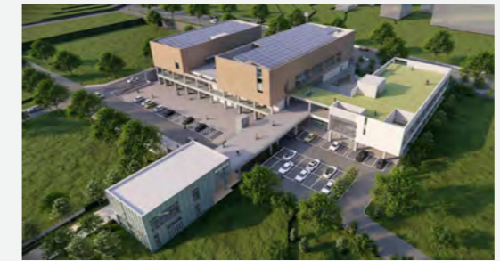
남해 생활SOC 꿈나눔센터 건립사업 건설사업관리 Construction Management for Namhae Life SOC Dream Sharing Center. 연면적 : 9,504㎡ 규모 : 지하 1층 / 지상 3층 위치 : 경상남도 남해군 G.F.A : 9,504㎡ Scale : B1 / 3F Location : Namhae-gun, Gyeongsangnam-do 경상남도 남해군 Namhae-gun, Gyeongsangnam-do 경기도 양평군 Yangpyeong-gun, Gyeonggi-do
