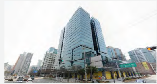
대령포스트타워 5차 신축공사 건설사업관리 Construction Management for Daeryung Post-Tower the 5th 연면적: 67,597㎡, 규모: 지하 4층 / 지상 20층 위치: 서울특별시 G.F.A: 67,597㎡, Scale: B4 / 20F Location: Seoul 리앤리어드바이저스 Lee & Lee Advisors
