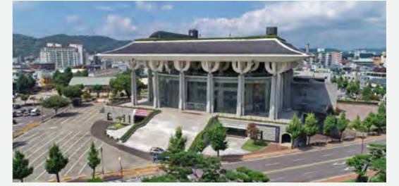
경상남도문화예술회관 개.보수 (리모델링)공사 건설사업관리 Construction Management for Gyeongsangnam-do Culture & Art Center Remodeling 연면적 : 6,537㎡, 규모 : 지하 2층 / 지상 2층 위치 : 경상남도 진주시 G.F.A : 6,537㎡, SCALE : B2F / 2F LOCATION : Jinju-si, Gyeongsangnam-do 경상남도 문화예술회관 Gyeongnam Culture & Art Center
