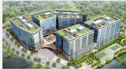
의왕포일 2지구 C2블럭 지식산업센터 신축공사 건설사업관리 Construction Management for Uiwang Foil District 2 IT Valley 연면적: 199,116㎡ 규모: 지하 3층 / 지상 10층, 위치: 경기도 의왕시 G.F.A: 199,116㎡, Scale: B3 / 10F Location: Uiwang-si, Gyeonggi-do 디지털프리즘 DIGI PRISM
