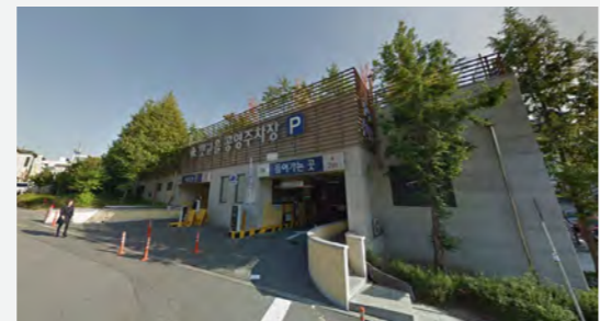
성남시 공영주차장 설치공사 건설사업관리 Construction Management for Public Parking Lot in Seongnam-si 연면적: 5,689㎡, 규모: 지하 3층, 지상 1층 위치: 경기도 성남시 G.F.A: 5,689㎡ Scale: 3 basement level, 1 ground Floors Location: Seongnam-si, Gyeonggi-do 경기도 성남시 Seongnam-si, Gyeonggi-do
