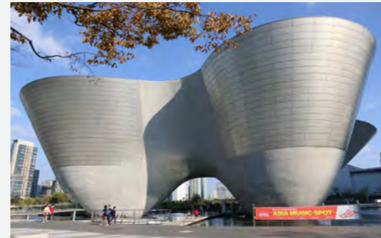
2009년 인천세계도시엑스포 기념관 건립 등 건설사업관리 Construction Management for Global Fair & Festival 2009 Incheon Memorial Hall 연면적 : 2,644㎡, 규모 : 지하 1층 / 지상 3층 위치 : 인천광역시 연수구 G.F.A : 2,644㎡, SCALE : B1F / 3F LOCATION : Yeonsu-gu, Incheon 포스코건설 POSCO E&C
