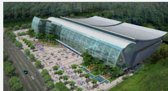
창원컨벤션센터 증축공사 건설사업관리 Construction Management for Changwon Convention Center 연면적 : 41,322㎡ 규모 : 지상 6층, 위치 : 경상남도 창원시 G.F.A : 41,322㎡, SCALE : 6F LOCATION : Changwon-si, Gyeongsangnam-do 경상남도 창원시 Changwon-si, Gyeongsangnam-do
