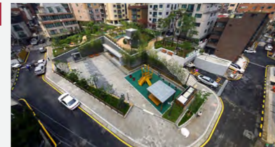
방배1동 공영주차장 신축공사 건설사업관리 Construction Management for Public Parking Lot in Bangbae 1 Dong 연면적: 5,724㎡ 규모: 지하4층, 지상1층, 위치: 서울 서초구 G.F.A: 5,724㎡ Scale: 4 basement level, 1 ground Floors Location: Seocho-gu, Seoul 서울특별시 서초구 Seocho-gu, Seoul Metropolitan Government
