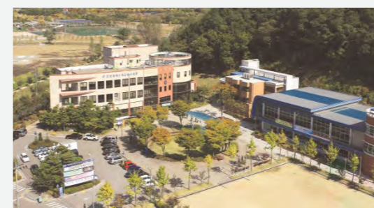
인천 청소년수련관 기능보강공사 건설사업관리 Construction Management for Incheon Youth Center 연면적: 6,344㎡ 규모: 지하1층, 지상3층 위치: 인천 남동구 G.F.A: 6,344㎡ Scale: 1 basement level, 3 ground Floors Location: Namdong-gu, Incheon 인천광역시 Incheon Metropolitan City
