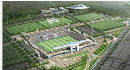
창원시 축구센터 건립사업 건설사업관리 Construction Management for Changwon Football Center 연면적 : 21,932㎡, 규모 : 지하 1층 / 지상 4층 위치 : 경상남도 창원시 G.F.A : 21,932㎡, SCALE : B1F / 4F LOCATION : Changwon-si, Gyeongsangnam-do 경상남도 창원시 Changwon-si, Gyeongsangnam-do
