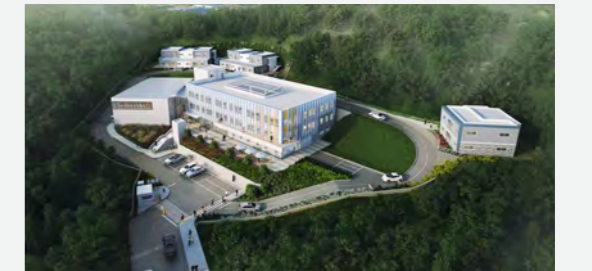
국립 경상권 청소년치료재활센터 건립사업 건설사업관리 Construction Management for The National Center for Youth Rehabilitation in Gyeongsang-do Province 연면적: 67,597㎡ 규모: 지하4층, 지상3층, 위치: 대구 달성군 G.F.A: 67,597㎡, Scale: 2 basement level, 5 ground Floors Location: Dalseong-gun, Daegu 여성가족부 Ministry of Gender Equality and Family
