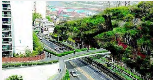
응봉산~대현산간 생태통로 건설 기본 및 실시설계 Preliminary and Detailed Design for Eungbongsan-Daehyeonsan Ecological Bridge Construction 길이: 53.0m Length: 53.0m 성동구 Seongdong-gu Office
