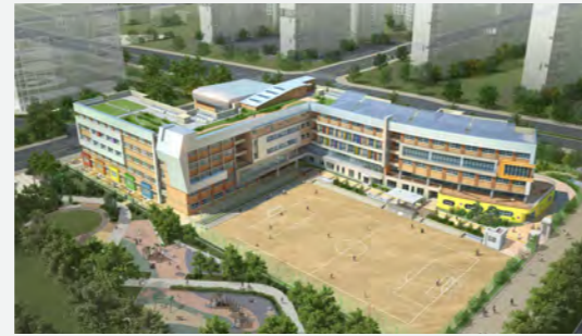
삼송2초외1교(별내6초) 임대형 민자사업(BTL) 통합 건설사업관리 Construction Management for Samsong 2 Elementary School and Byeolnae 6 Elementary School 연면적 : 28,628㎡ 규모 : 지하 1층 / 지상 5층 위치 : 경기도 고양시, 남양주시 G.F.A : 28,628㎡ SCALE : B1F / 5F LOCATION : Goyang-Namyangju-si, Gyeonggi-do 초록나무꿈 Green Tree Dream Corporation
