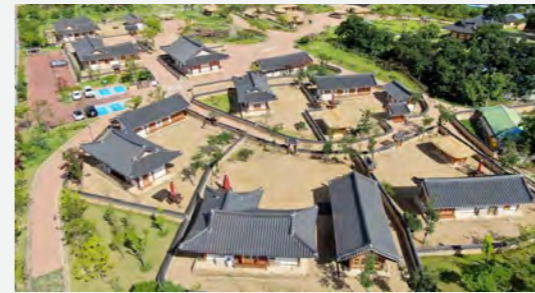
2014 신라불교문화초전지, 역사문화 디지털센터, 강동문화복지회관 건설사업관리 Construction Management for Silla Buddhism Culture Diffusion Site, History & Culture Digital Center, Cultural Welfare Center 연면적 : 15,819㎡ 규모 : 지하 1층 / 지상 1층 위치 : 경상북도 구미시 G.F.A : 15,819㎡, SCALE : B1F / 1F LOCATION : Gumi-si, Gyeongsangbuk-do 경상북도 구미시 Gumi-si, Gyeongsangbuk-do
