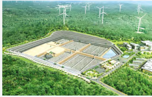
제주환경자원순환센터(매립시설) 조성사업 기본설계 Preliminary Design for Jeju environmental resource circulation center (landfill facility) creation project 면적: 210,350m 2 Area: 210,350m 2 코오롱글로벌(주) Kolon Global Co.
