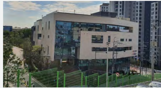
염리종합사회복지관 건립공사 건설사업관리 Construction Management for Yeomri Social Welfare Center 연면적 : 8,047㎡, 규모 : 지하 2층 지상 4층, 위치 : 서울 마포구 G.F.A : 8,047㎡, Scale : 2 basement level, 4 ground Floors Location : Mapo-gu, Seoul 서울시특별시 마포구 Mapo-gu, Seoul Metropolitan Government
