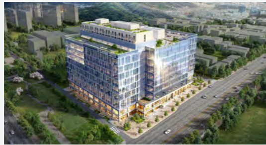
서대구산업단지 복합시설 건축공사 건설사업관리 Construction Management for Seodaegu Industrial Complex Facility 연면적 : 91,016㎡ 규모 : 지하 2층 / 지상 11층 위치 : 대구광역시 서구 G.F.A : 91,016㎡ Scale : B2F / 11F Location : Seo-gu, Daegu 케이비부동산신탁 KB Real Estate Trust
