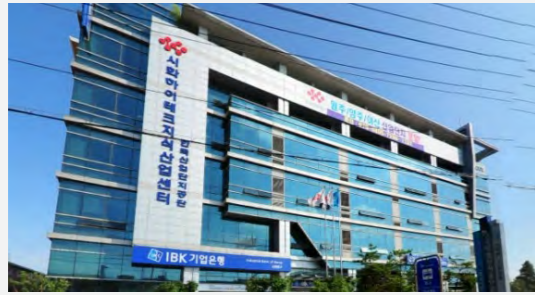
시화하이테크 아파트형공장 신축공사 건설사업관리 Construction Management for Sihwa Hightech Venture Center 연면적: 9,918㎡ 규모: 지하 1층 / 지상 5층 위치: 경기도 시흥시 G.F.A: 9,918㎡ Scale: B1 / 5F Location: Siheung-si, Gyeonggi-do 한국산업단지공단 Korea Industrial Complex Corporation
