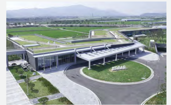
한국원자력 환경공단본사 사옥 기본 및 실시설계 Preliminary and Detailed Design for Headquarter of Korea Radioactive Waste Agency 대지면적 : 31,888㎡ 연면적 : 12,365㎡ 경주시 Site Area : 31,888㎡ G.F.A. : 12,365㎡, Gyeongju 한국원자력환경공단 KORAD
